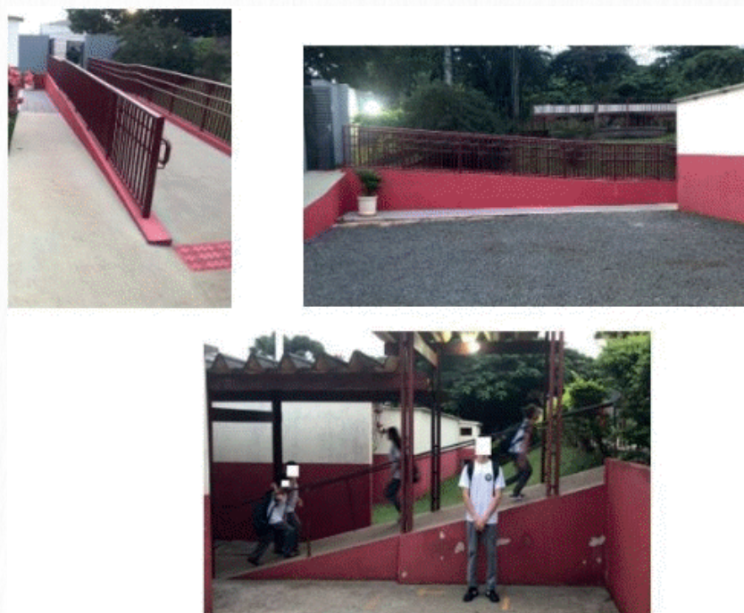
Figura 1: Rampa de acesso de um bloco a outro de uma escola
