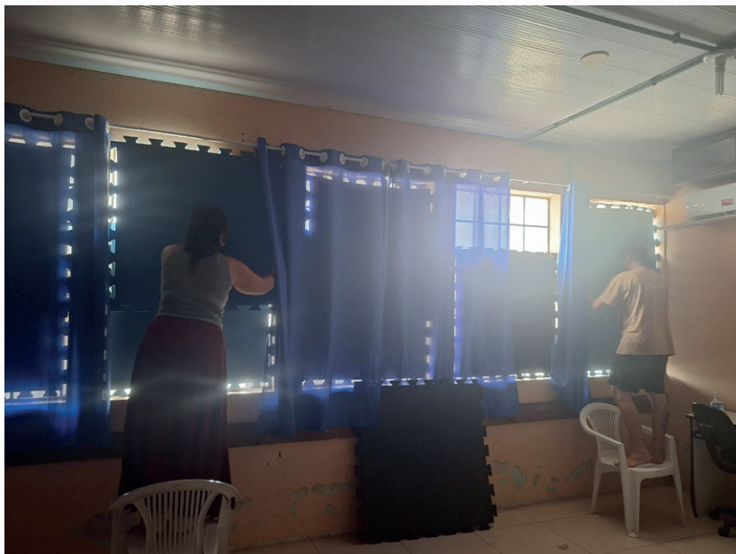
Figura 1: Processo de isolamento da sala de aula com tatames de EVA.
