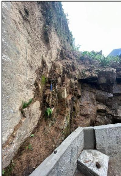
Figura 3 - Afloramento de rocha pouco alterada bastante fraturado.
