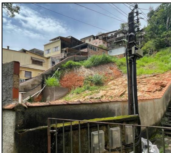
Figura 4 - Exemplo de Solo Raso Sobre Rocha, evidenciado após deslizamento translacional raso com consequente exposição de afloramento de rocha.
