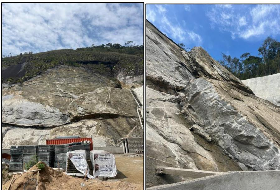
Figura 2 - Afloramento de rocha exposto devido à obra realizada no local, ocorre solo raso sobre rocha nas partes mais altas. Em alguns pontos, ocorrem afloramentos de rocha pouco alterada.
