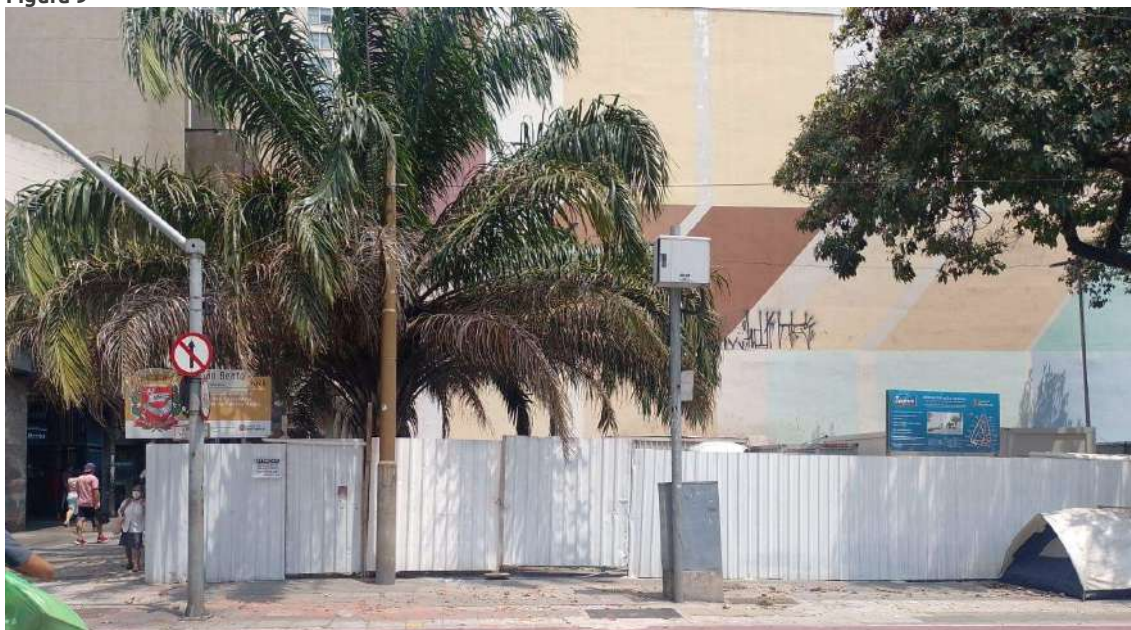
Largo São Bento atualmente, transformado em canteiro de obras, com tapumes e barracas dos moradores de rua. Fonte: os autores.
