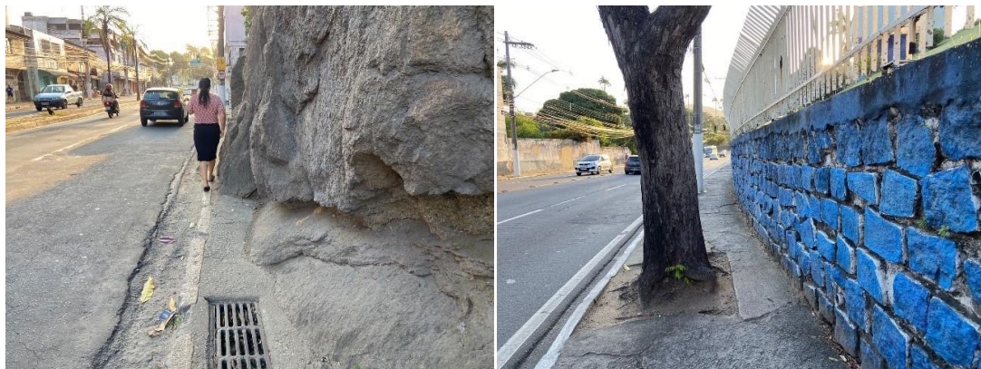
Imagem 1: Calçadas inadequadas e inacessíveis
