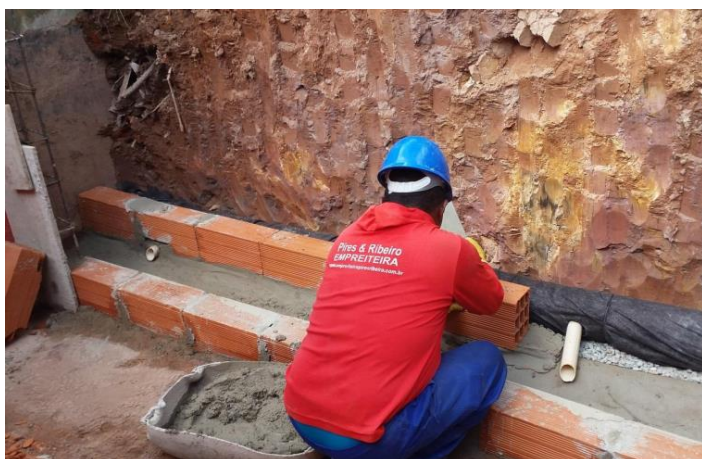
Figura 15: Parede dupla sendo executada em moradia pelo programa “Tá Bonito”
