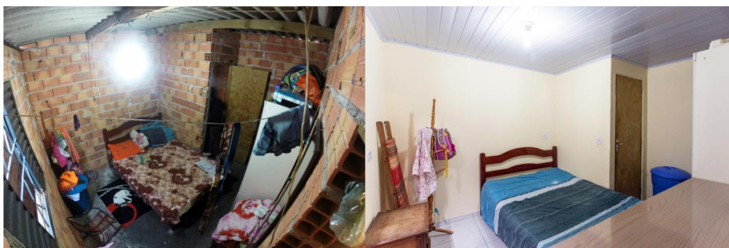
Figura 19 e 20: Imagens de Antes e Depois de obras realizadas pela Vivenda entre 2014 e 2017.
