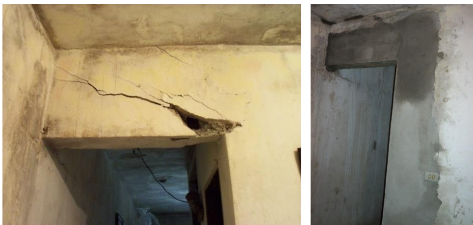
Figura 6 e 7: Requalificação estrutural (antes, durante e depois) no município de Taboão da Serra com recursos do PSH.
