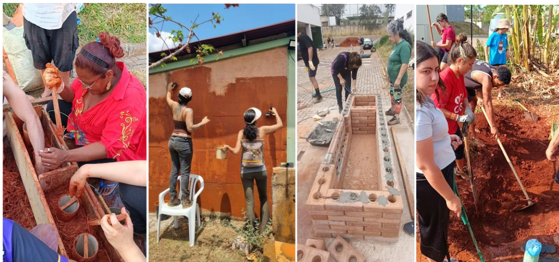
Figura 4: Capacitação Técnico-Social para construção civil
