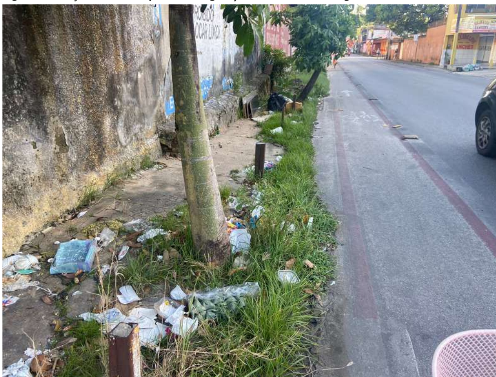
Figura 16 - Calçada obstruída por lixo e vegetação na Rua Alberto Magno
