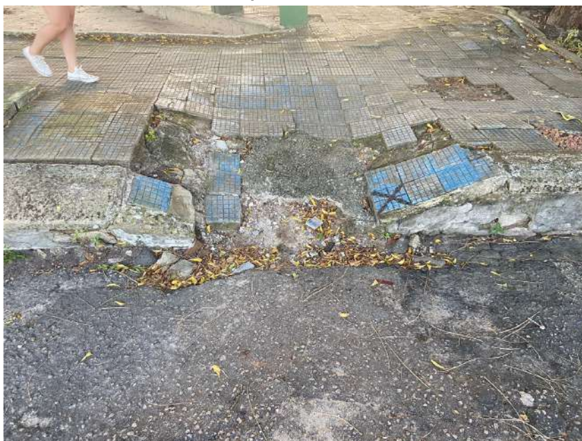
Figura 35 - Rampa de acesso da praça
