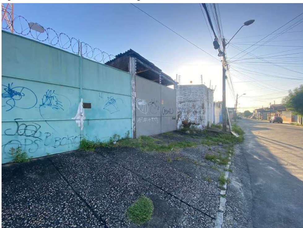
Figura 29 - Fachada inativa Rua Eduardo Angelim
