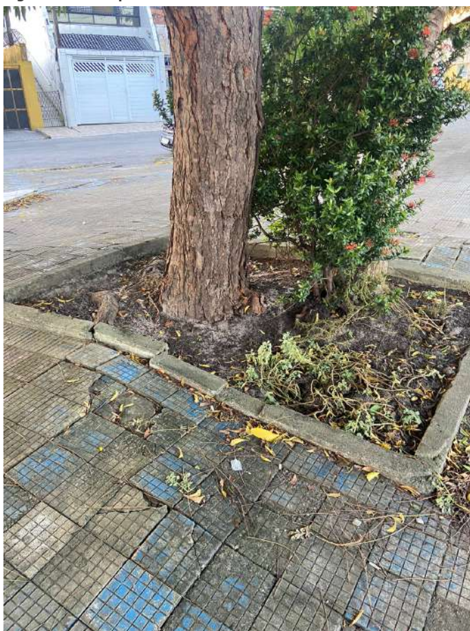
Figura 34 - Piso quebrado
