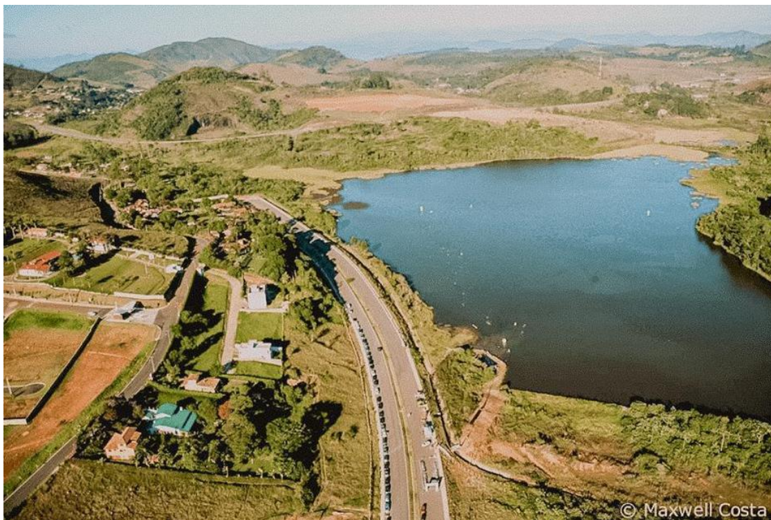
Figura 5: Trecho da BR-440 próximo à Represa de São Pedro mostra-se um risco para o manancial.
