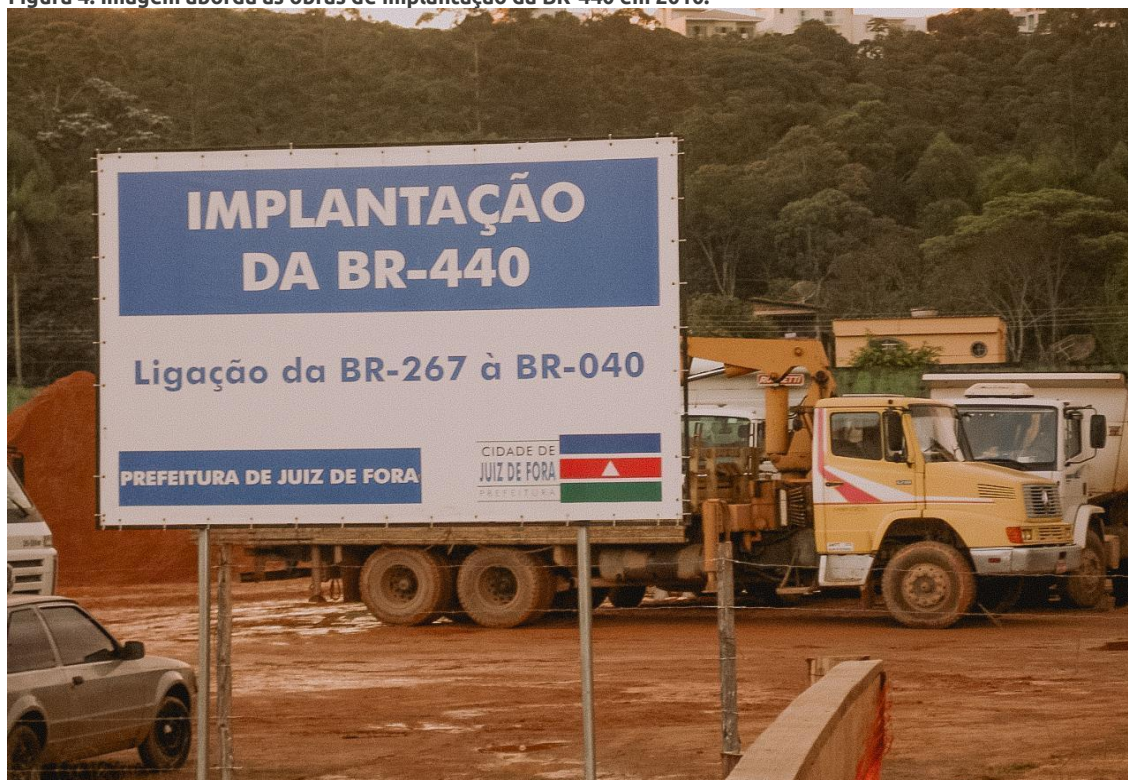
Figura 4: Imagem aborda as obras de implantação da BR-440 em 2010.
