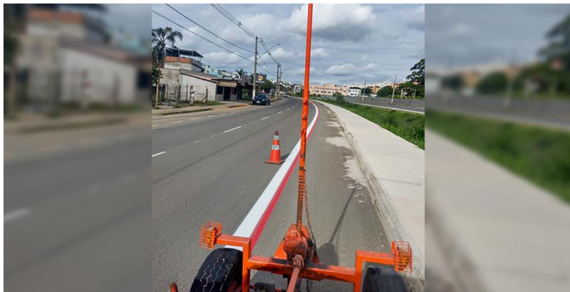
Figura 19: Prefeitura de Juiz de Fora inicia a instalação de Ciclofaixa em trecho da Nova Via São Pedro, antiga BR-440.
