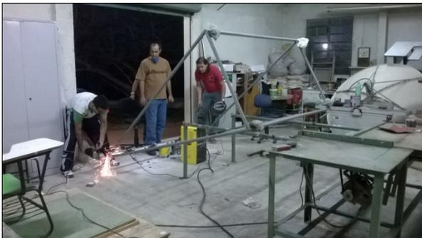
Figura 3 - Soldagem da estrutura do experimento
