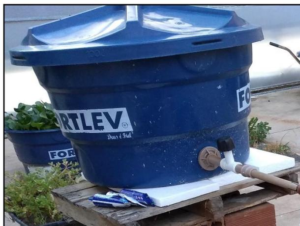
Figura 2. Reservatório utilizado para controle de vazão do efluente para o biodigestor. Fonte: Autor (2021).
